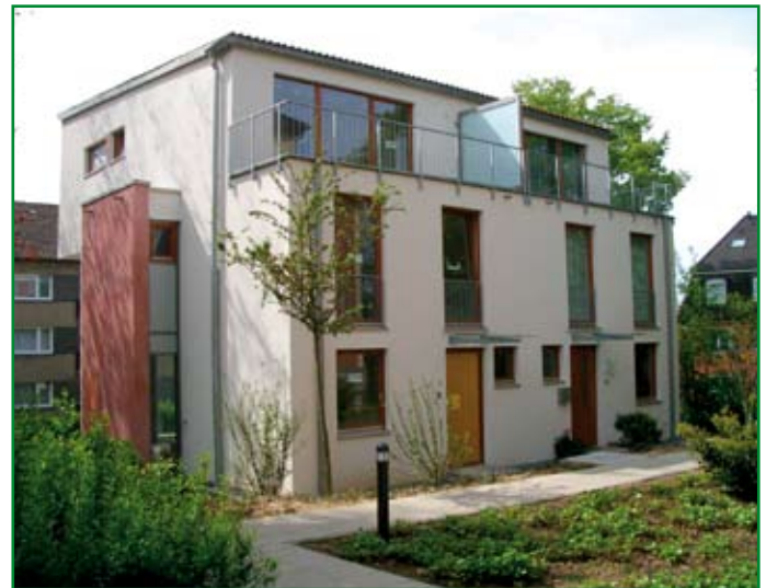
Doppelhaus an der Leyer Straße
