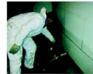
Einbringen des Dichtmaterials
