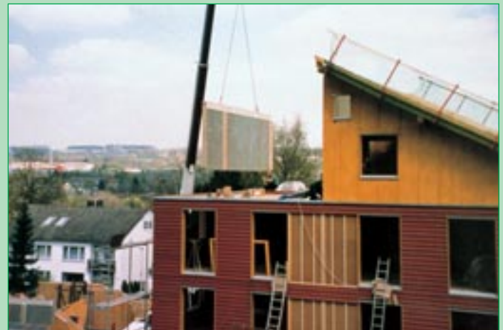
Niedrigenergiehaus in Wuppertal
