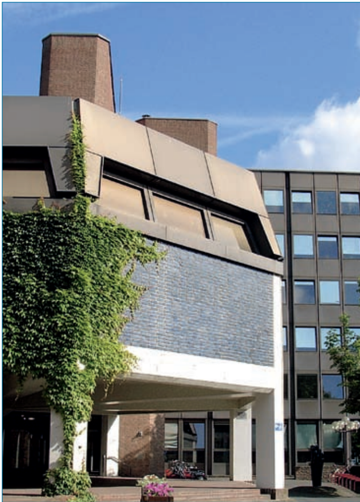
Der Eingangsbereich des Weseler Rathauses
