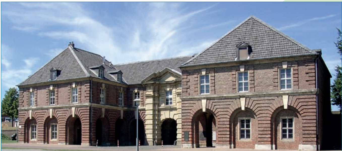
Haupttorgebäude der Weseler Zitadelle
