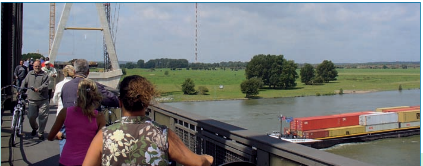
Attraktiver Anziehungspunkt: Die Baustelle der neuen Niederrheinbrücke Wesel
