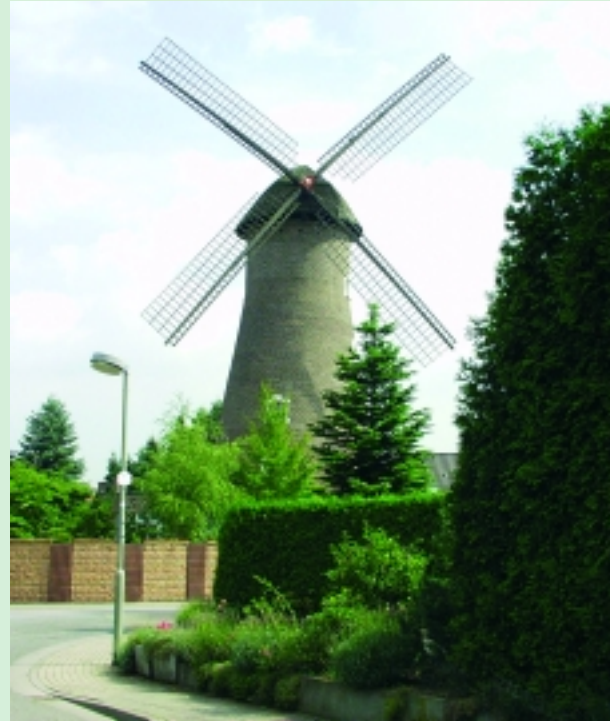
Mühle Weßling Hamminkeln
