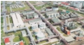
ECI Elektro-Chemie GmbH, Werk Bitterfeld
