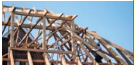
Beispiel Flachdachaufstockung
