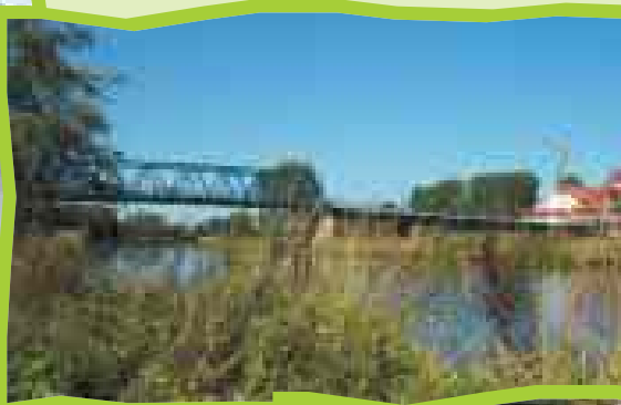
Emsbrücke – Emmelner Straße
