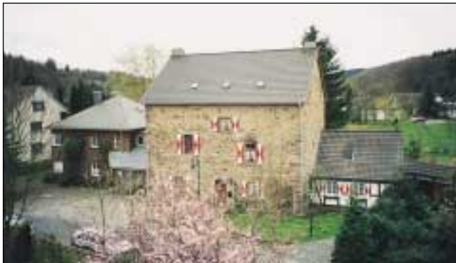
Neubau an histor. Bausubstanz, Beispiel Sülzer Burg Foto: Dipl.-Ing. N. Sturm
