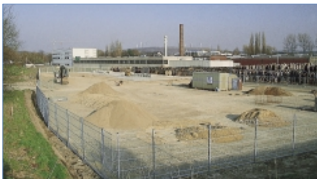
Gesamtansicht Kabelwerk FACAB Lynen, Dürener Straße
