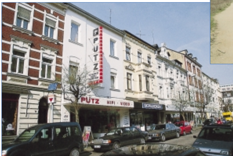
Häuser der Gründerzeit Eschweiler, Rosenallee
