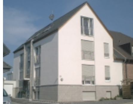
Bauvorhaben: Preyerstr. 77, Eschweiler
