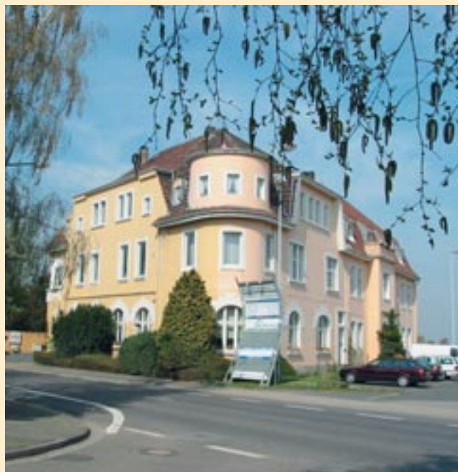
■ Verwaltungsgebäude der ehemaligen Zuckerfabrik in Ameln
