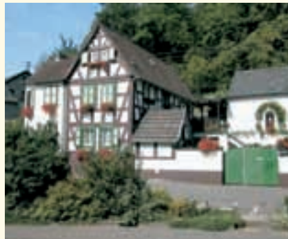
Altes Fachwerkhaus in Kasbach-Ohlenberg, Ortsteil Kasbach
