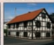
Umbau u. Sanierungen
