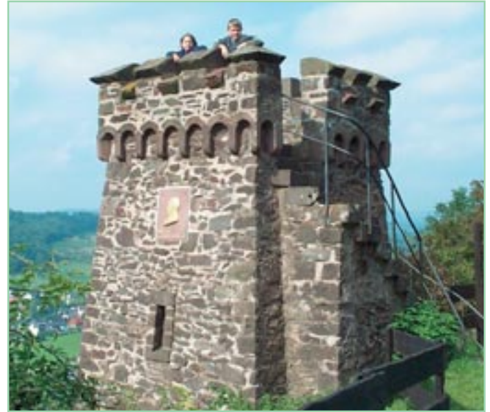
■ 100 Jahre alter Bismarckturm in Schoden
