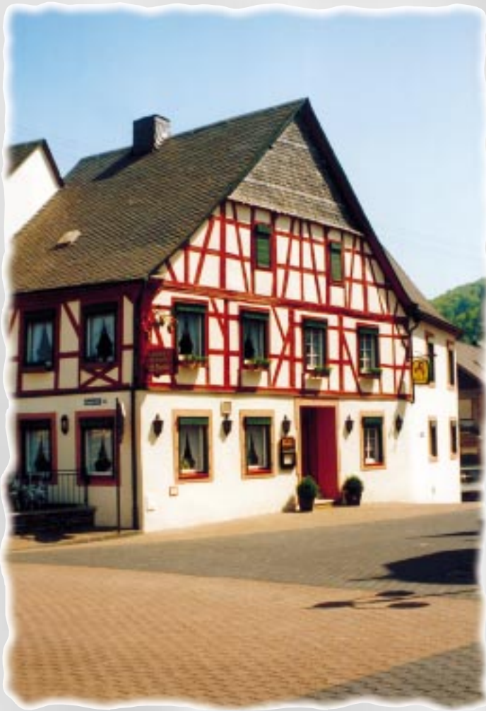
Fachwerkhaus in Veldenz
