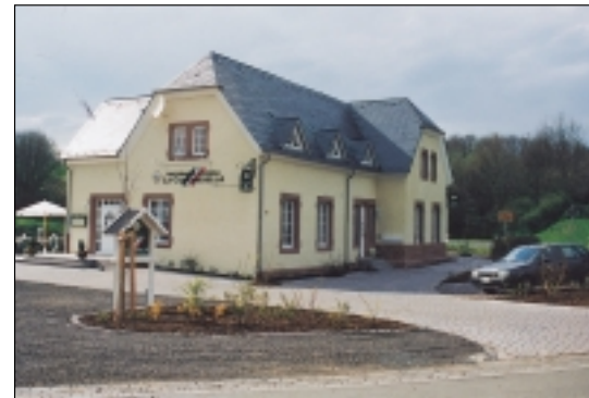
Umbau des ehemaligen Bahnhofs in Bleialf in eine Gaststätte (nachher)
