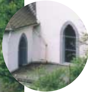
Wallfahrtskapelle „St. Jost“ bei Langenfeld / Eifel
