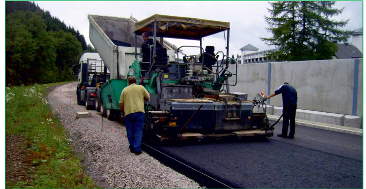
Die Asphaltierungsarbeiten schreiten voran.
