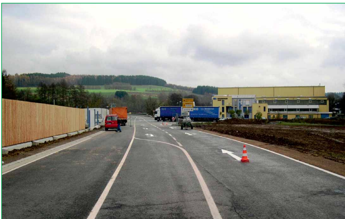
Die letzten Arbeiten laufen.
