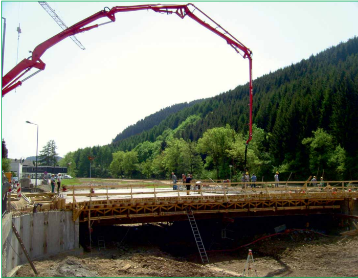
Die Brücke über die Sieg im Zuge der „Amtsstraße“ wird betoniert.
