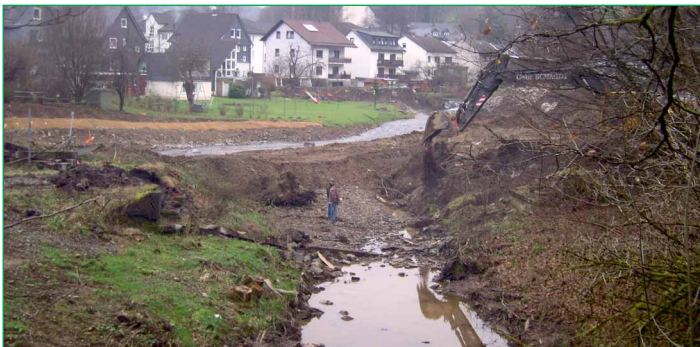
Ein Höhepunkt im Verlauf der Arbeiten: „Die Sieg wird in ihr neues Bett verlegt“.
