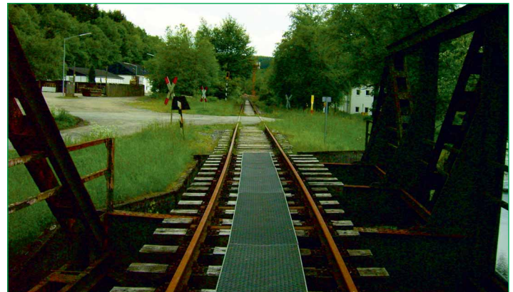
Auch die Brückenbauwerke der Siegener Kreisbahn mussten abgebrochen werden.
