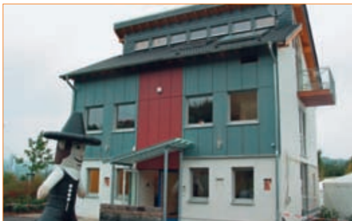
Das TeamWerk-Haus der Kreishandwerkerschaft Hagen ist ein Treffpunkt für Handwerk, Planer, Hersteller, Handel und Bürger
