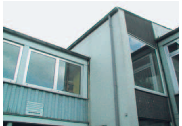
Vorher: Detail der Fassade an der Erlenbachschule
