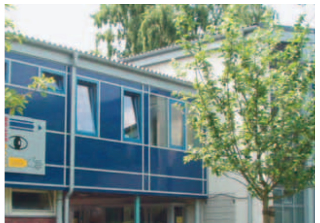
Nachher: Detail der sanierten Fassade
