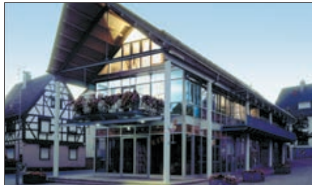
Die Kanzlei in Hösbach
