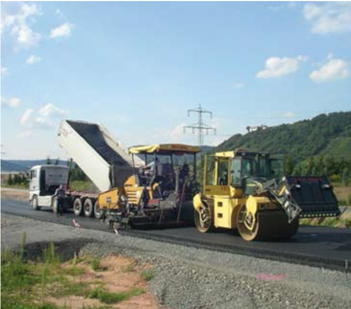
Asphalteinbau auf der St 2309 (Bild: StBA AB)
