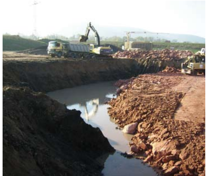
Schwierige Bodenverhältnisse: Erdbauarbeiten im Torf (Bild: StBA AB)
