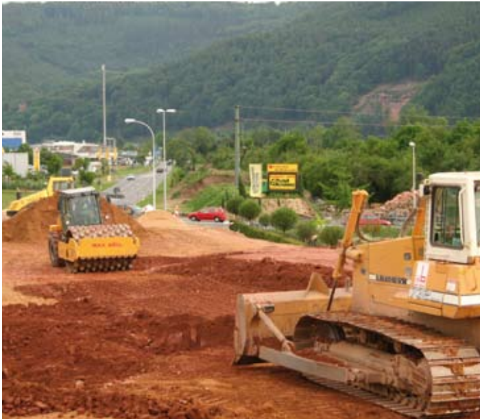
Einbau von Erdbaumaterial mit Zertrümmerungswalze und Raupe (Bild: MZ Mil)
