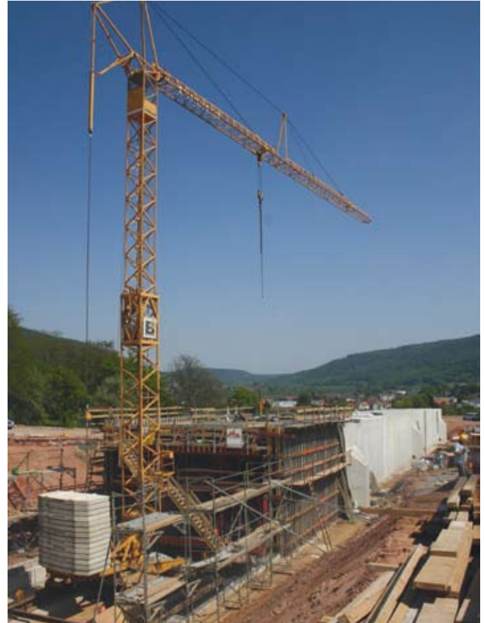
Tunnelbaugrube mit Schalwagen (Bild: MZ Mil)
