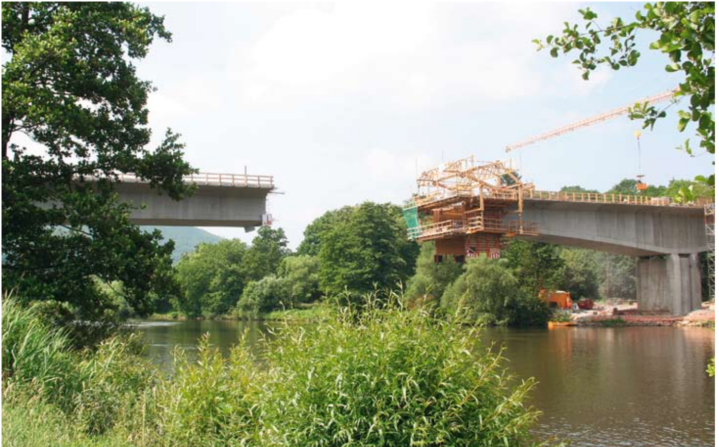
Freivorbau der Mainbrücke Miltenberg-Bürgstadt (Bild: AK)
