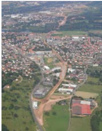
Bauarbeiten im August 2006 (Bild: StBA AB)
