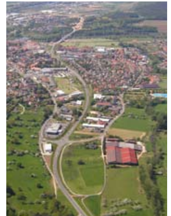
Bauarbeiten im Mai 2008 (Bild: StBA AB)
