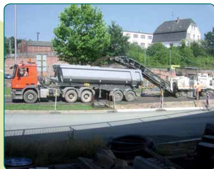
Fräsarbeiten Knoten Hanauer Straße
