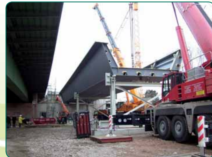
„Herstellung Stahlüberbau auf Lehrgerüst“
