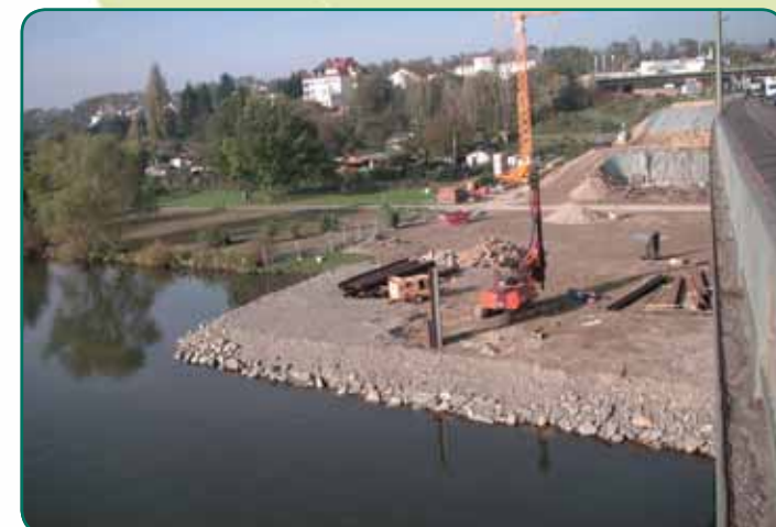
„Mainschüttung mit Spundung für Herstellung Flusspfeiler“
