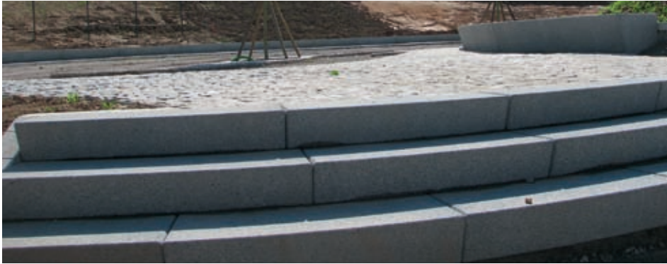
Treppenstufen und Sitzblöcke laden zum Verweilen und Entspannen ein.
