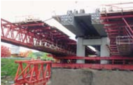
Waschenbachtalbrücke im Bauzustand
