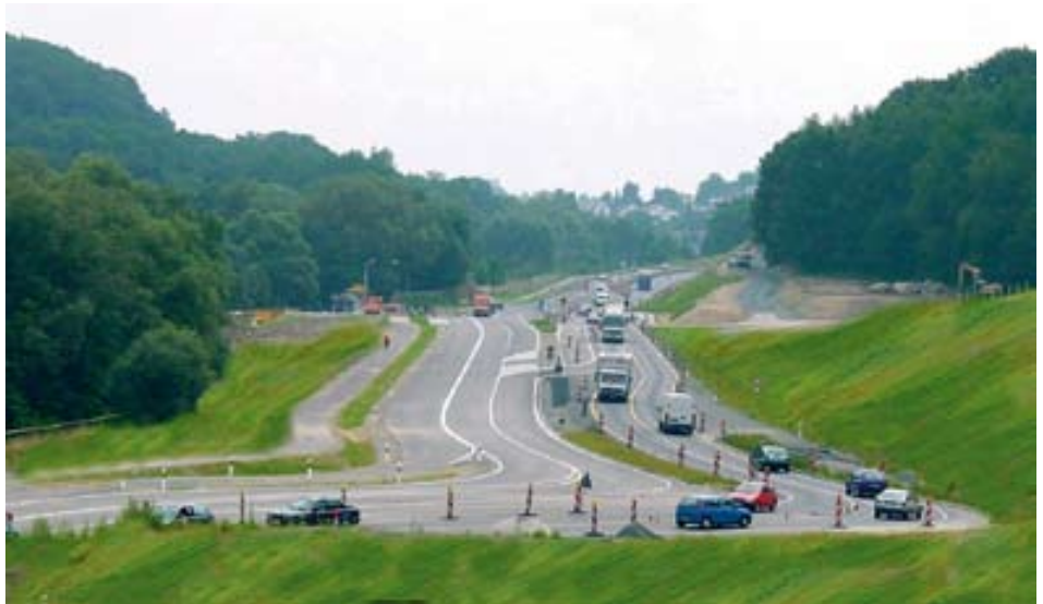
Streckenbau nördlich des Tunnels
