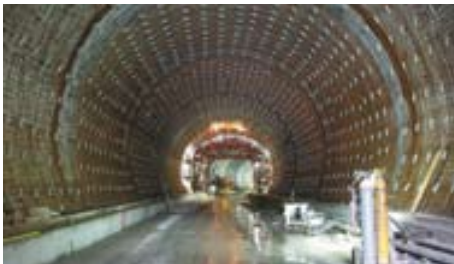
Bewehrung der Tunnelinnenschale
