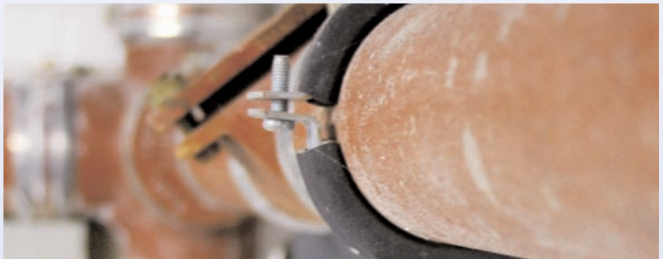
Entwässerungsleitung mit Revisionsöffnung
