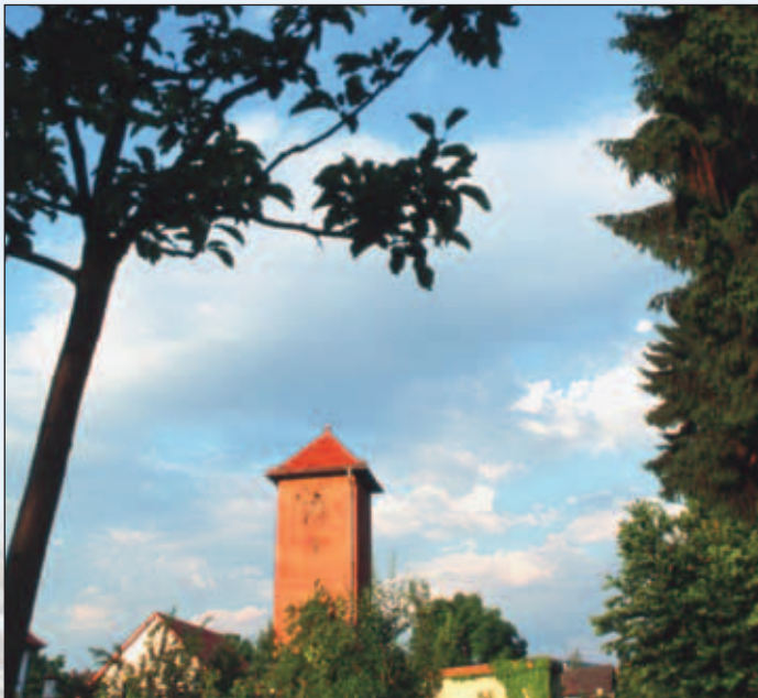
Altes Trafo-Häuschen – jetzt Nistplatz der Turmfalken
