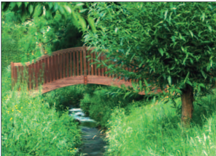
Brücke über Hintergraben
