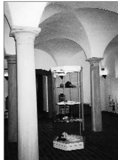
Der renovierte Kreuzgewölberaum mit einer Ausstellungsvitrine
