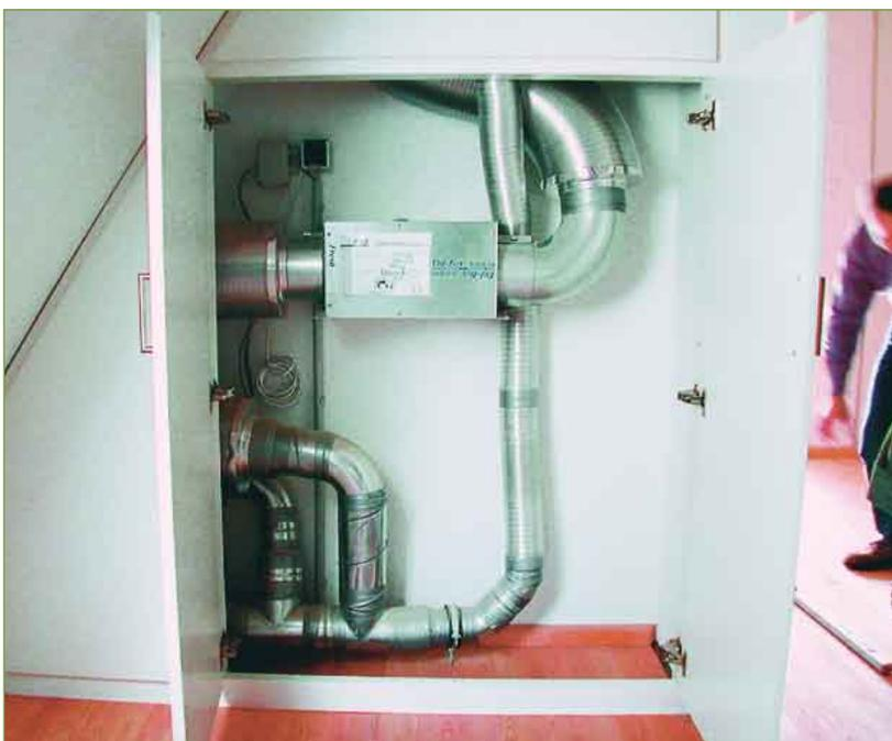
**Lüftungsanlagen werden platzsparend installiert und arbeiten sehr leise.**
