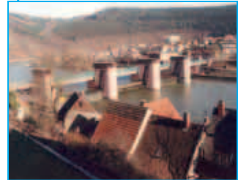
techn. Denkmal Neckarstaustufe Hirschhorn
