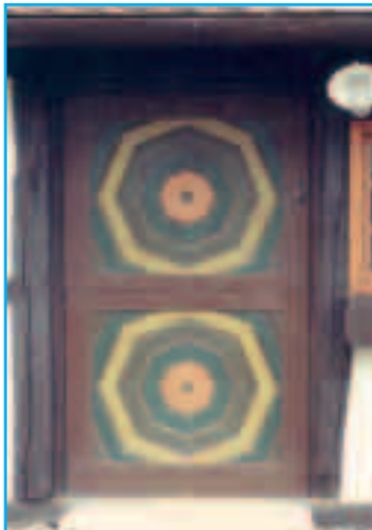
Eingangstür in Hammelbach
