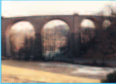
Viadukt der „Überwaldbahn“ bei Weiher
