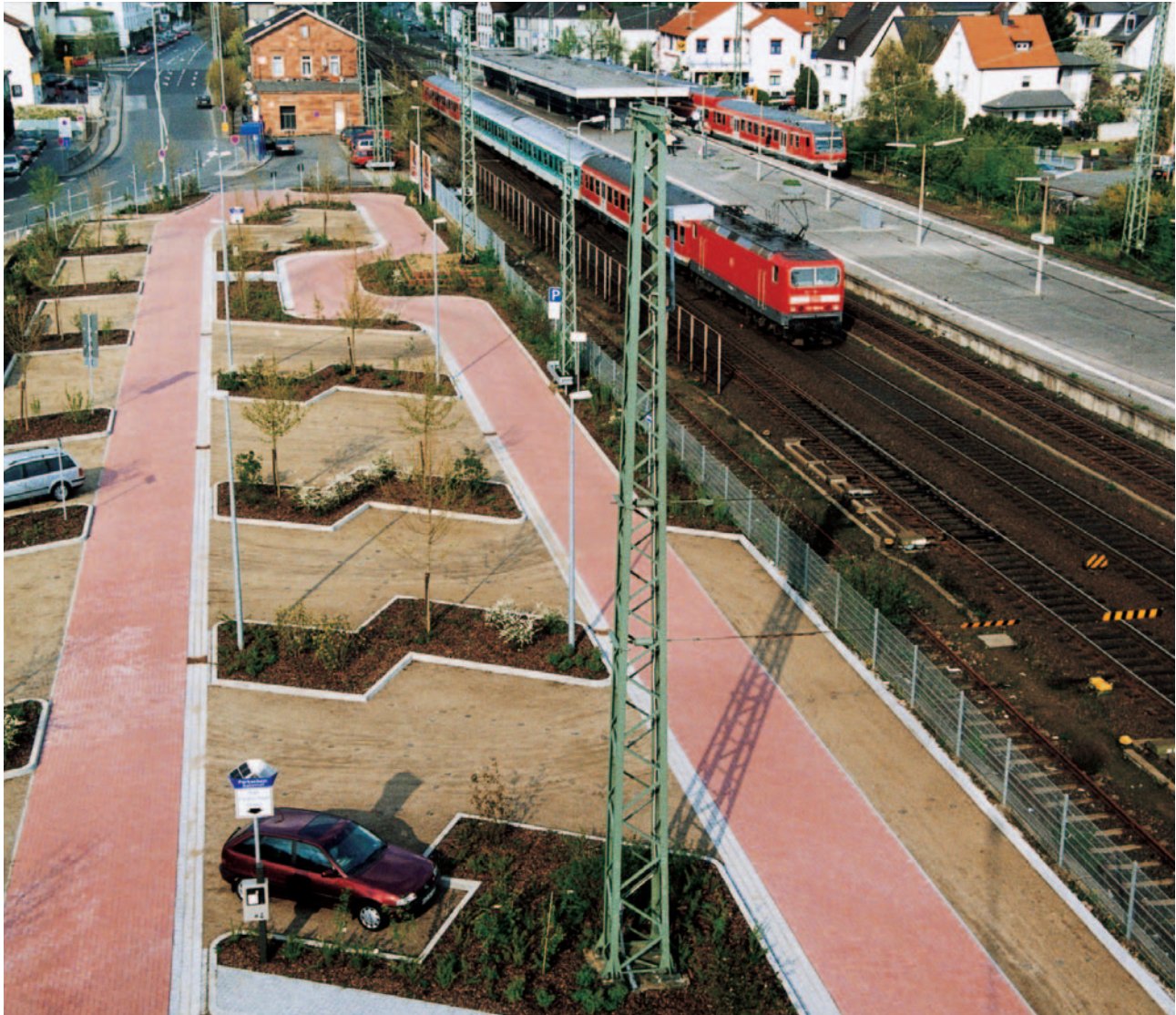
Moderne Infrastruktur – Bahnhof in Kelsterbach
