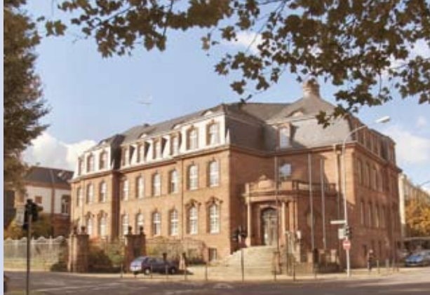
Hauptgebäude des Landratsamtes Saarlouis
