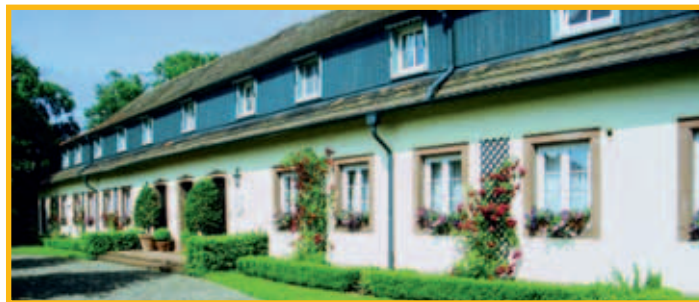
Historischer Gutshof „Linslerhof“
