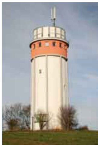
Wasserturm auf dem Sangerhof
