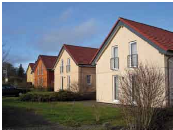
Ferienhäuser am Delmeshof in Quirnbach/Pfalz
