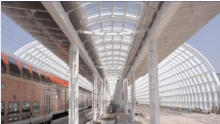
Die zweibogige Dachkonstruktion
