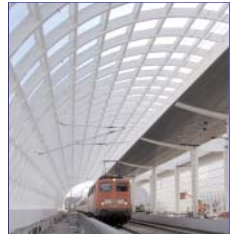
Zugdurchfahrt im neuen Bahnhof
