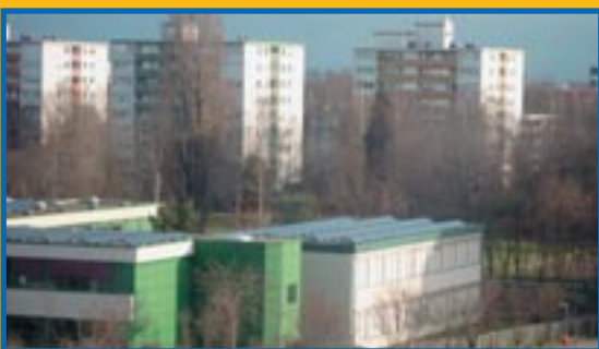
Photovoltaikanlage in Frankenthal (Quelle: Solartechnik Deimling)
