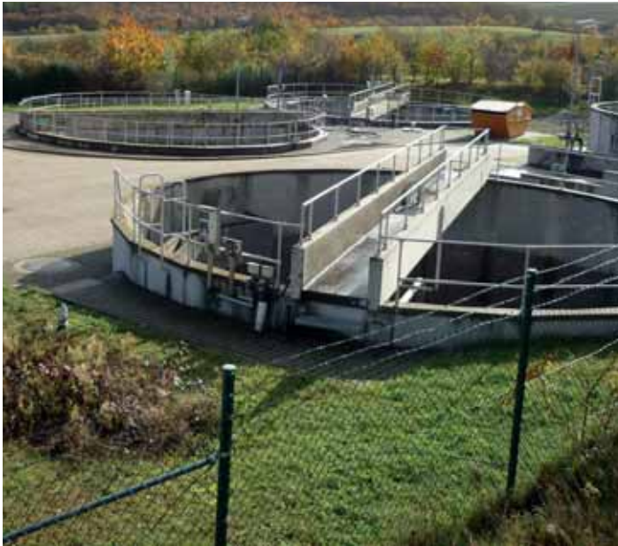
Kläranlage in Dannenfels
