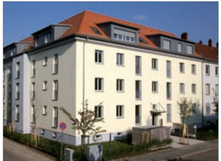
Saniert nach Niedrigenergiehausstandard: die „Blaue Heimat“ in Handschuhheim
