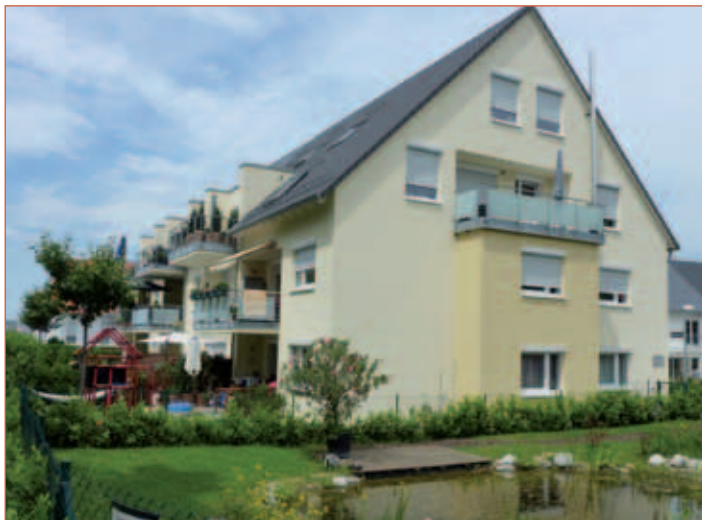
14 Eigentumswohnungen, Blaumeisenweg 12+14, Stuttgart-Weilimdorf, Activ Bau- und Projektentwicklungsgesellschaft mbH
