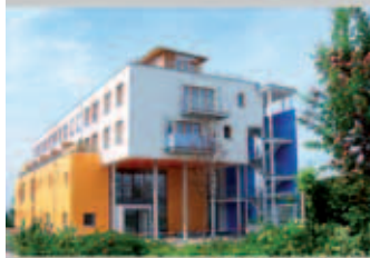
Baugemeinschaft mit Kita
