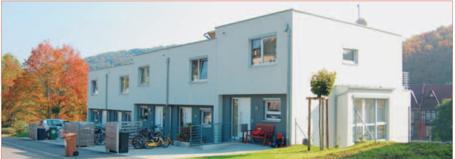
8 Reihenhäuser, Leonberger Straße, Stuttgart-Süd, Integralbau GmbH
