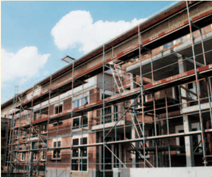
Rohbauten werden heute in relativ kurzer Zeit erstellt
