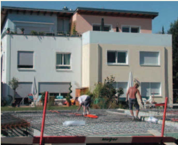
In Neubaugebieten gibt es oft noch eine Zeit größerer Belästigungen, wenn nebenan erschlossen oder gebaut wird
