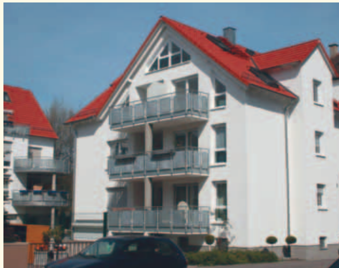
Über ungesicherte Balkone ins Haus?
