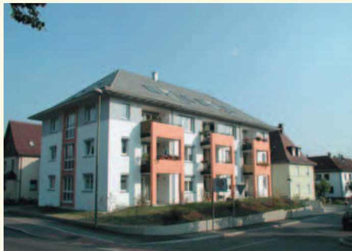
Beim Bauen im Bestand sollte man wie hier die Umgebungsbebauung berücksichtigen
