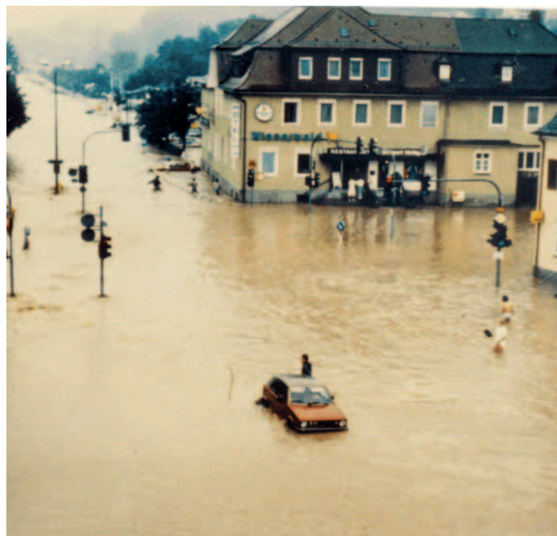
Adlerkreuzung in Tübingen-Lustnau beim Goldersbach-Hochwasser 1987
