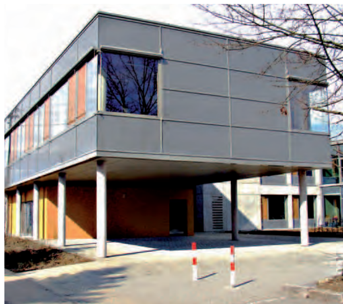
Die Berufliche Schule in Rottenburg – Anbau 2005.
