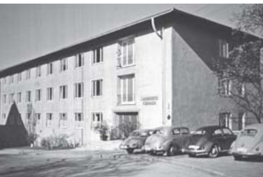
Das von Kreisbaumeister Zentner entworfene Gebäude in der Doblerstraße 15 (1951).
