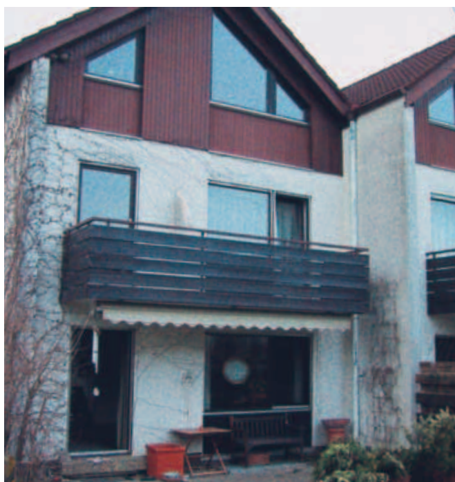
Erfolgreich sanieren ... vorher
