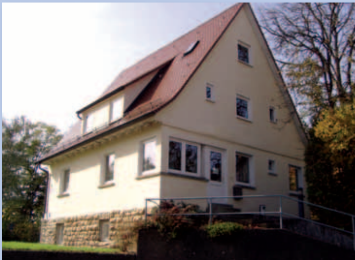
24 Dienstgebäude des BFD Ellwangen
