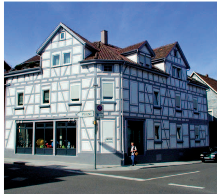
Fachwerk Binswanger Straße
