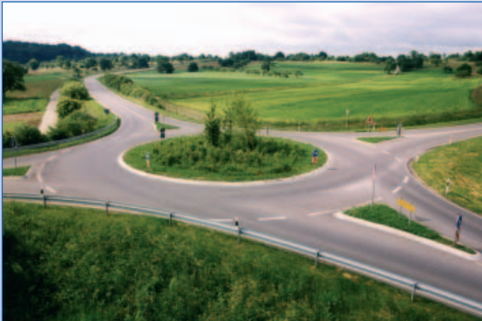
Der Bau von Kreisverkehren – wie hier bei Ispringen – trug wesentlich zur Erhöhung der Verkehrssicherheit im Enzkreis bei.
