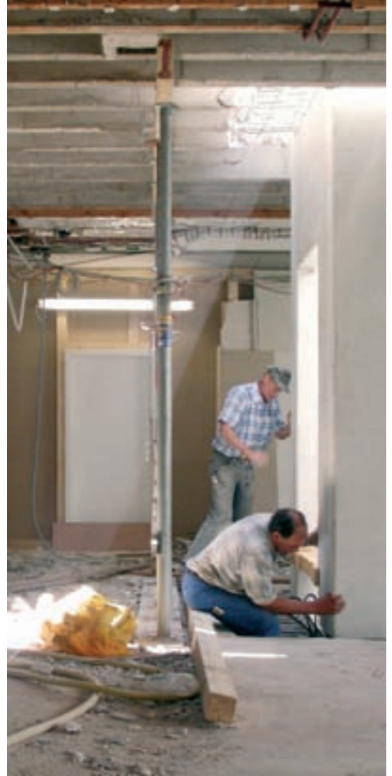
Anschluss des Aufzugsschachts an die Stahlbetondecken
