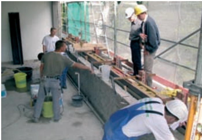
Betonsanierung an einer Fensterbrüstung
