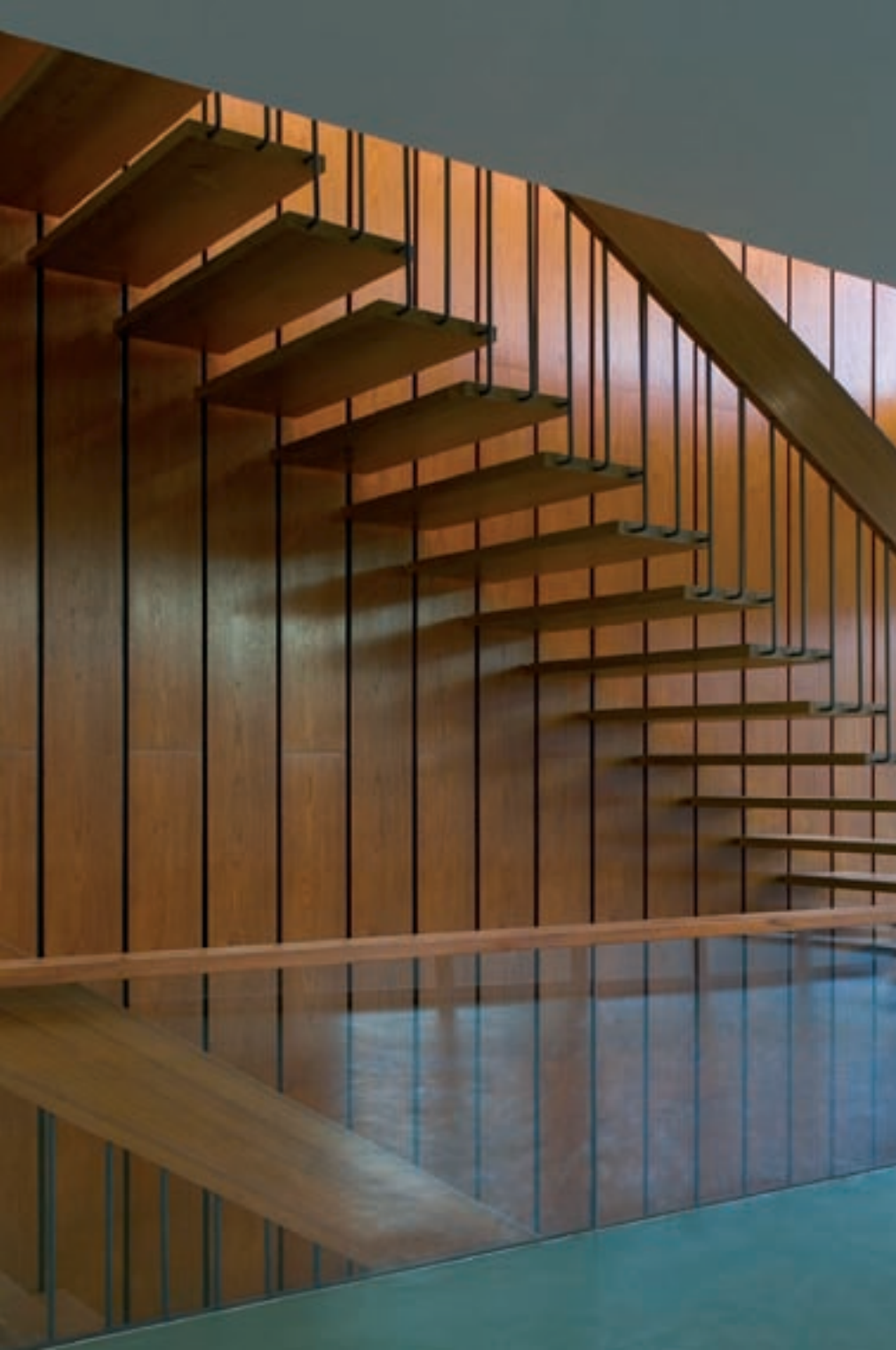
Die restaurierte feingliedrige Holz-Stahltrappe im künftigen Museumsshop
