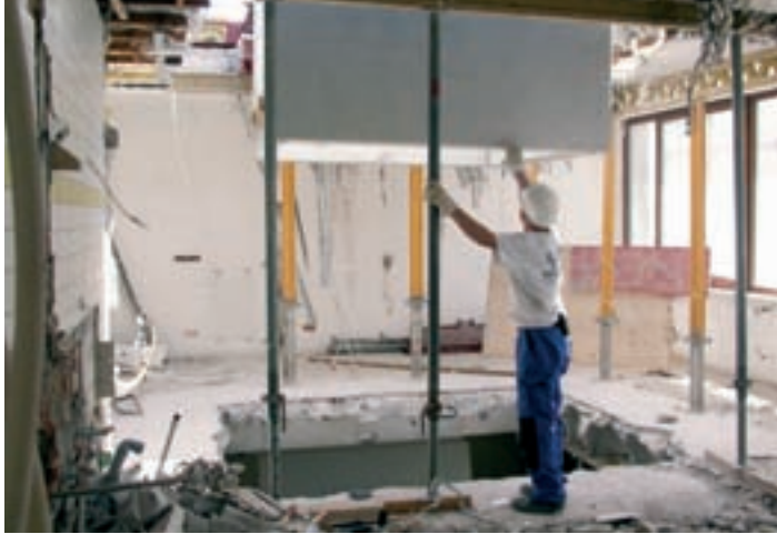
Einbringen des Aufzugsschachts
