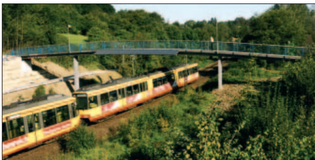
Neue Fußgängerbrücke beim „Mahler“
