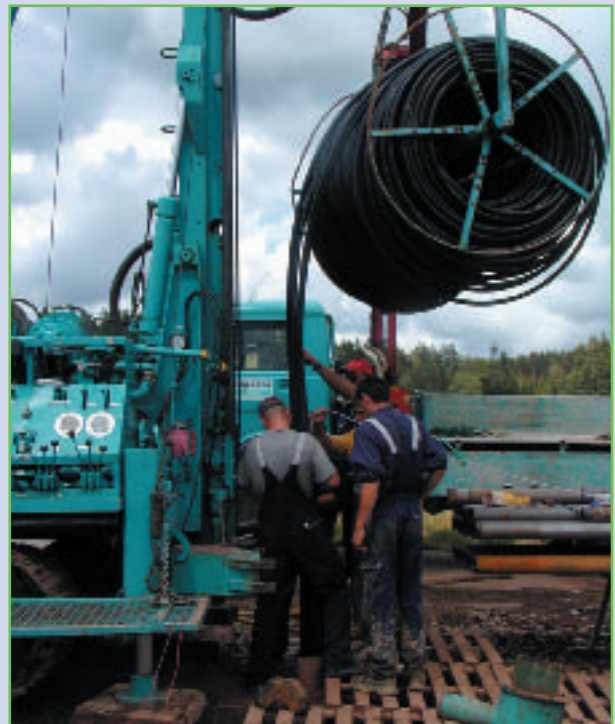
Durchführung einer Erdwärmebohrung
